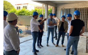
4 e kennissessie bij Draisma Bouw te Apeldoorn
